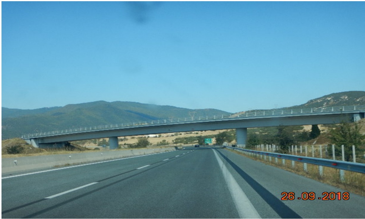
Άνω διάβαση στο σημείο που τέμνονται το εξεταζόμενο τμήμα με την παλαιά οδό.
