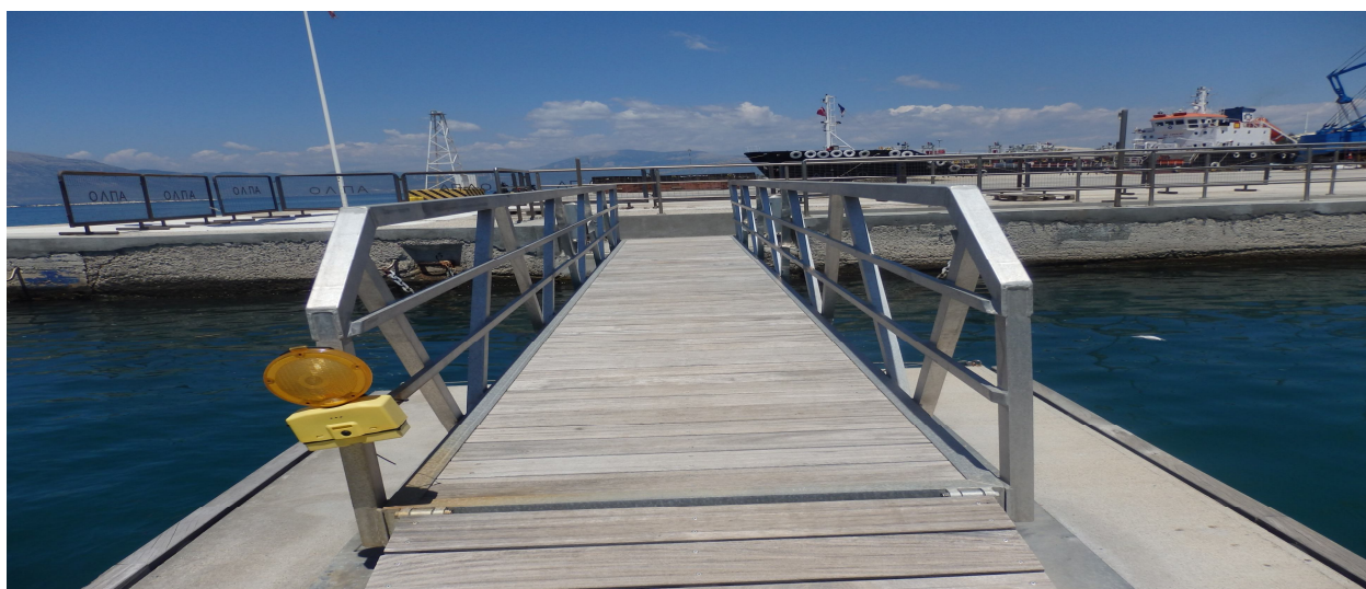
Φωτογραφία 4. Πλωτή ξύλινη ράμπα στερεωμένη με ογκόλιθους στον βυθό και αλυσίδες.
