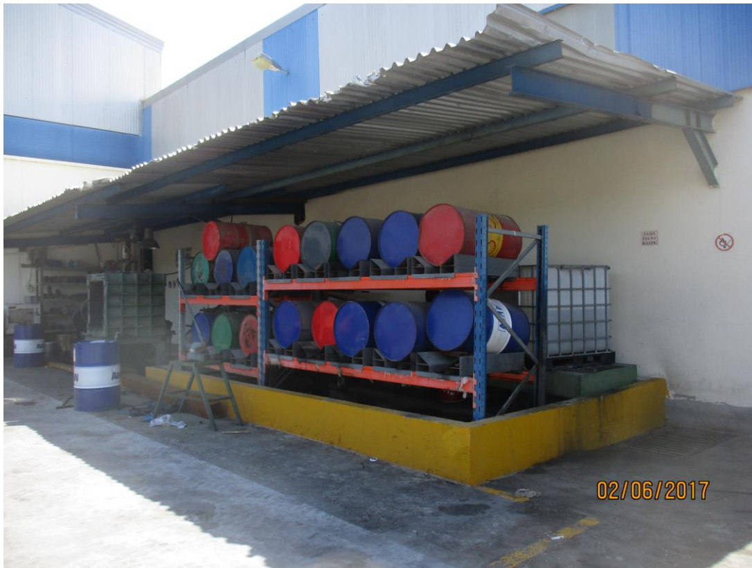
Φώτο 3: Χώρος αποθήκευσης χρησιμοποιημένων ελαίων.
