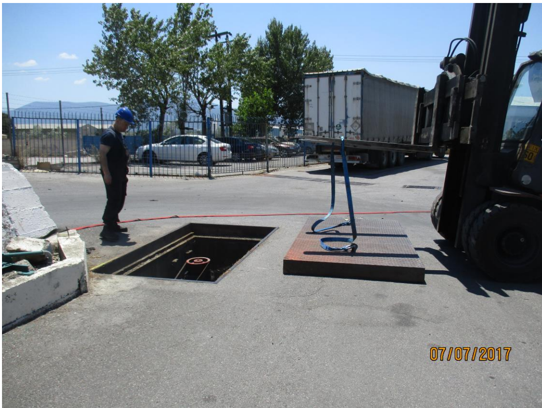
Φώτο 14: Γεώτρηση FITCO ΑΕ κατά την προσπάθεια λήψης δείγματος.
